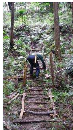
入口の階段作り
